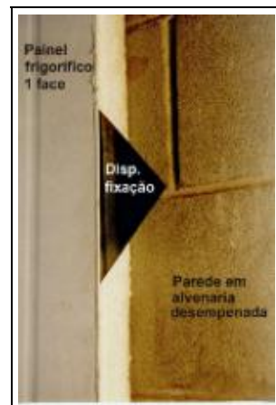
Detalhe da fixação Painel 1 face
