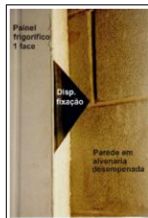
Detalhe da fixação Painel 1 face
